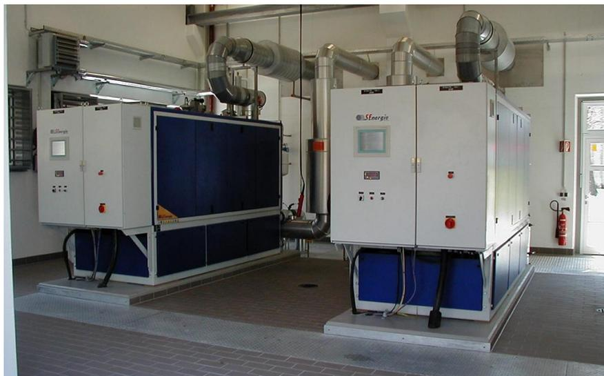
**Figura 1: Instalación con dos módulos compactos Senergie de 250 kWe/ud.**
